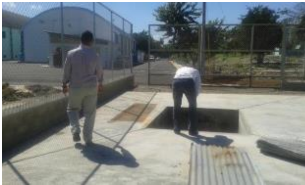
Figura 39 Construcción de nuevo Punto Verde en Almacén La Penda, en EDENORTE..
