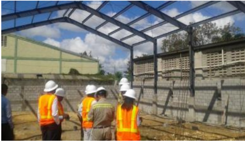
Figura 51. Construcción /adecuación del Taller en Hainamosa, EDEESTE..
