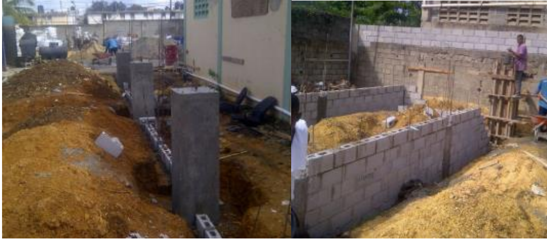
Figura 52. Construcción en proceso del taller de transformadores, Haina.
